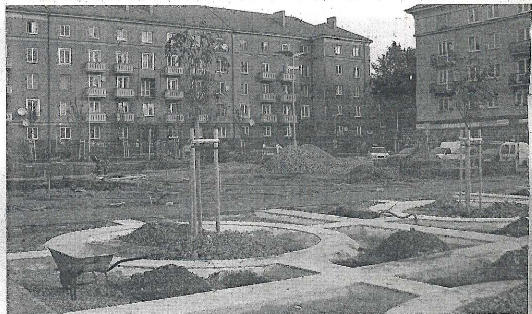
PRÁCE na náměstí finišují, hotová není ještě část před blokem domů, kde je pošta a restaurace Kotel.
