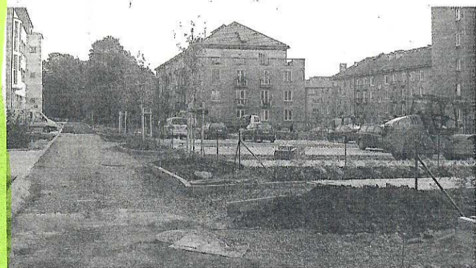
PRÁCE ve vnitrobloku Ve Dvoře pokračují budováním nových komunikací a parkovacích míst.
