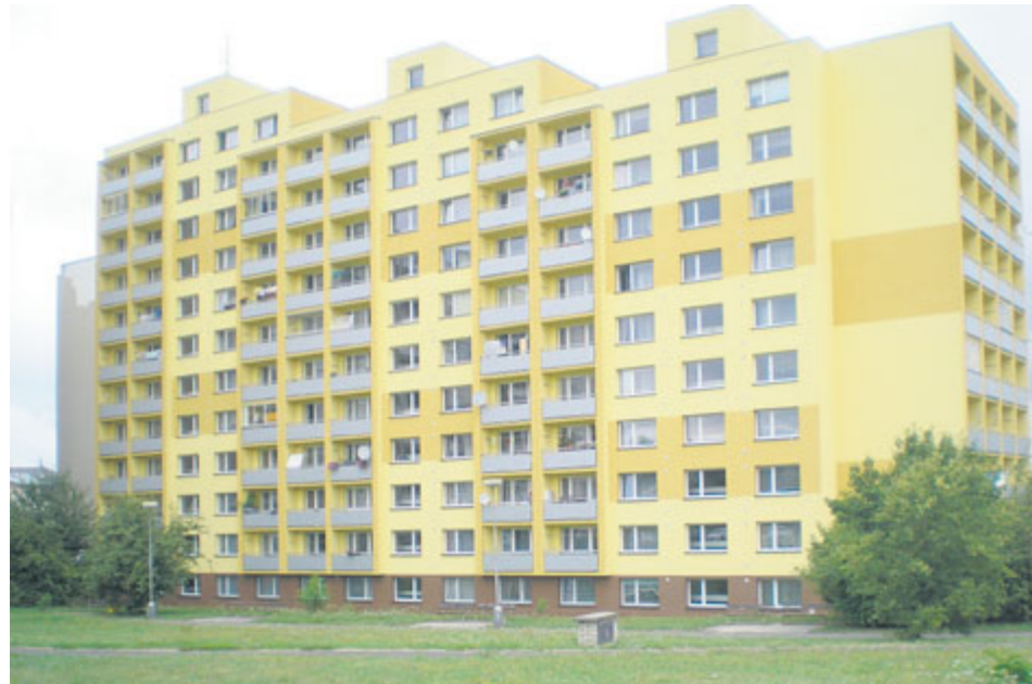
Domy pro seniory prošly v minulých letech kompletními rekonstrukcemi.
