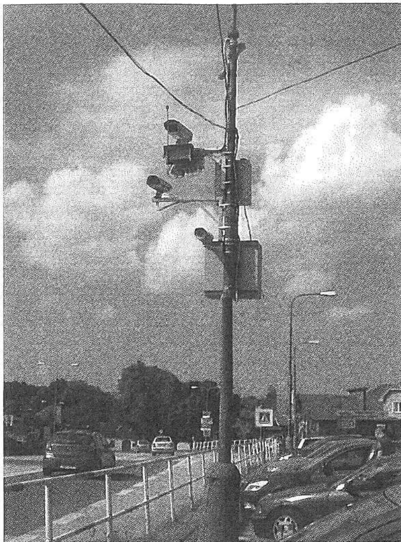
Obr. 4 Umístění kamer, detektoru přítomnosti vozidla a výpočetní jednotky na sloupu
