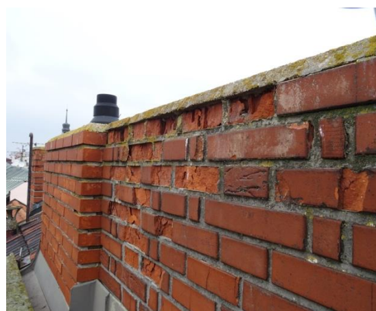
Obrázek č. 22 – Rozpad zdiva hlavy komínu [1]
