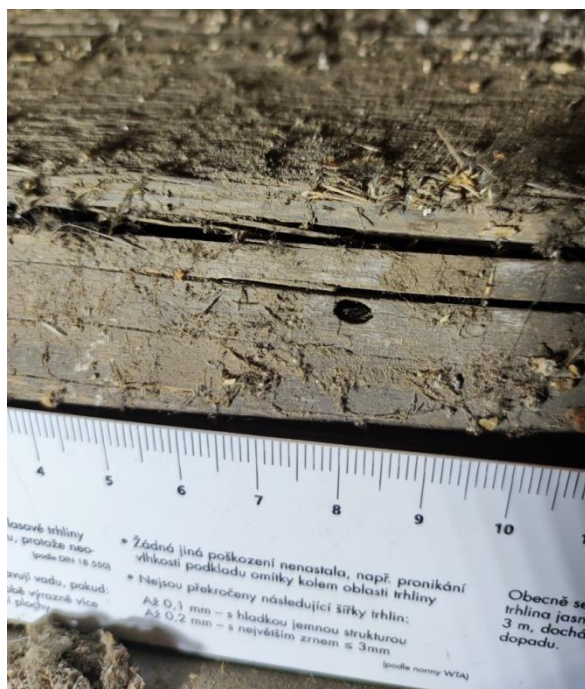
Obrázek č. 6 – Pozednice napadená dřevokazným hmyzem (tesařík) [1]
