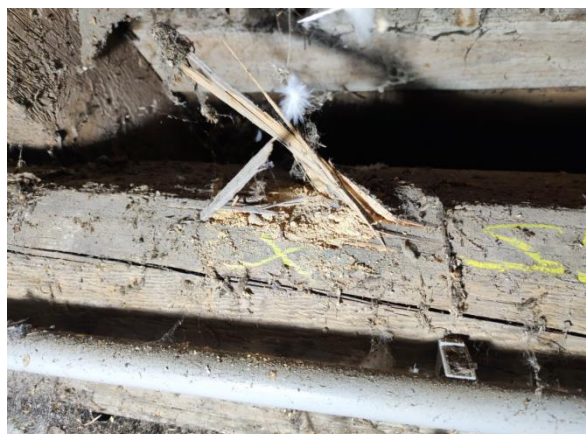
Obrázek č. 8 – Pozednice napadená dřevokazným hmyzem[1]
