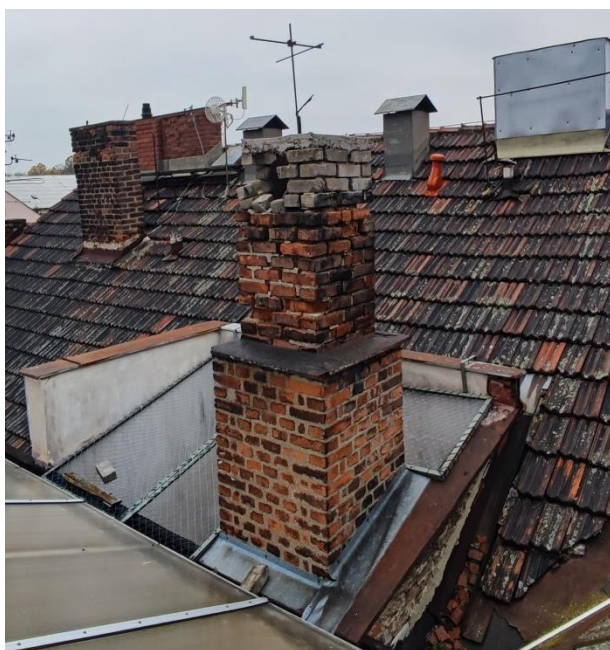
Obrázek č. 23 – Rozpad zdiva hlavy komínu [1]
