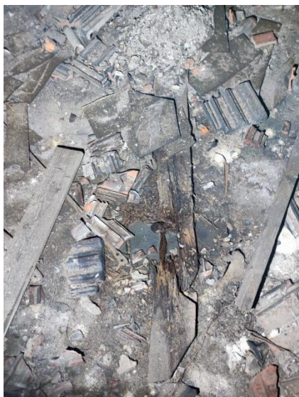
Obrázek č. 13 – Stopy po zátocích do půdního prostoru [1]
