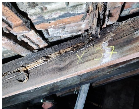
Obrázek č. 2 – Krokev napadená dřevokaznou houbou [1]
