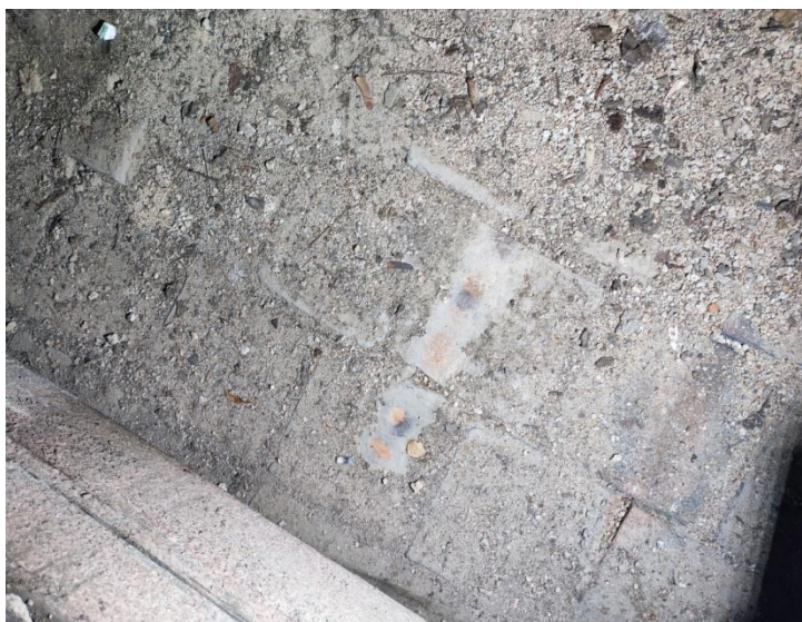
Obrázek č. 14 – Stopy po zátocích do půdního prostoru [1]
