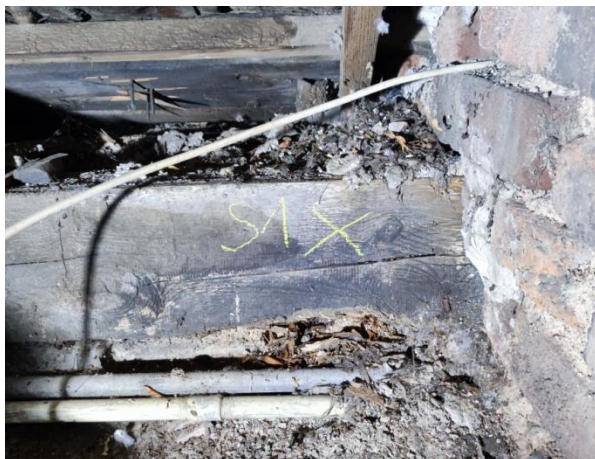
Obrázek č. 1 – Pozednice napadená dřevokaznou houbou [1]
