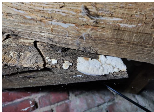
Obrázek č. 4 – Krokev napadená dřevokaznou houbou [1]
