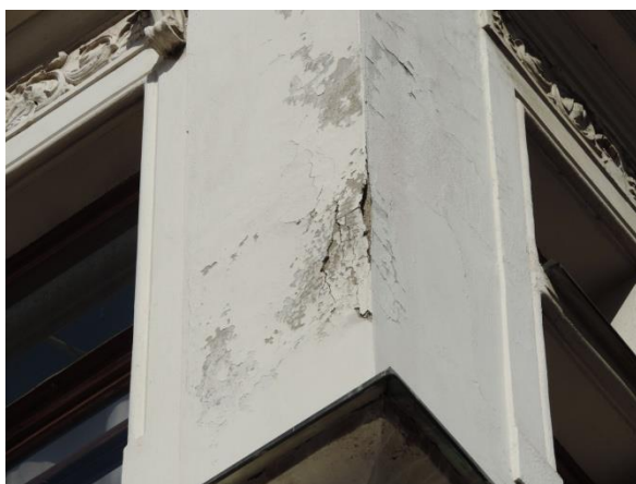
Obrázek č. 40 – Odpadávající vrchní i spodní vrstva omítky v místě svislých ploch arkýře [1]
