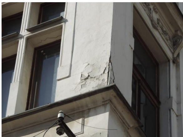
Obrázek č. 42 – Odpadávající vrchní i spodní vrstva omítky v místě svislých ploch arkýře [1]
