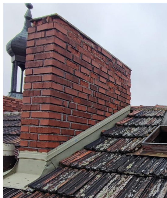
Obrázek č. 24 – Rozpad zdiva hlavy komínu [1]
