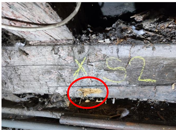
Obrázek č. 7 – Pozednice napadená dřevokazným hmyzem[1]
