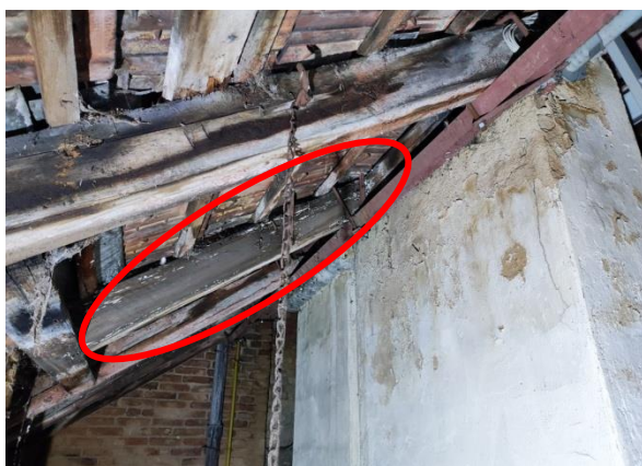
Obrázek č. 3 – Krokev napadená dřevokaznou houbou [1]
