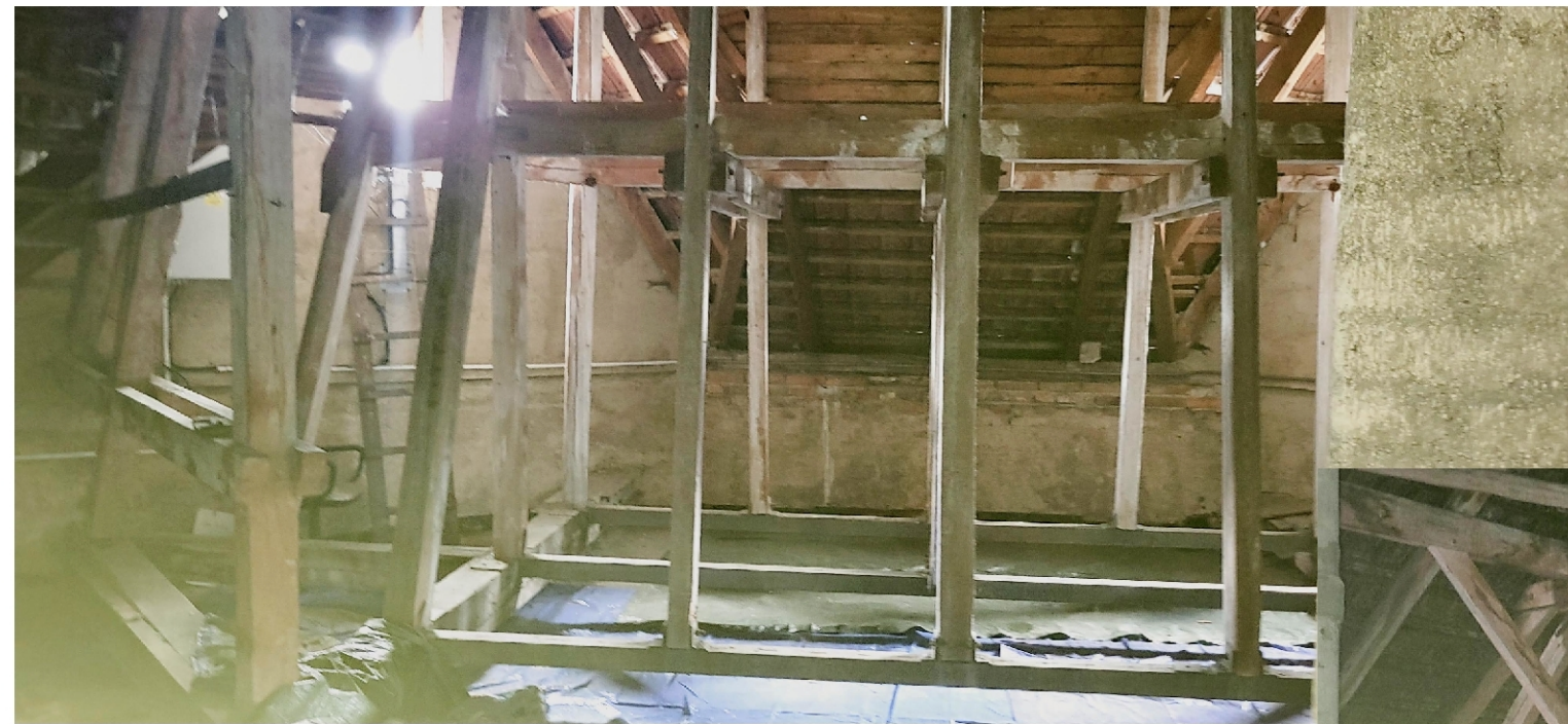
Podkroví - nárožní konstrukce krovu
