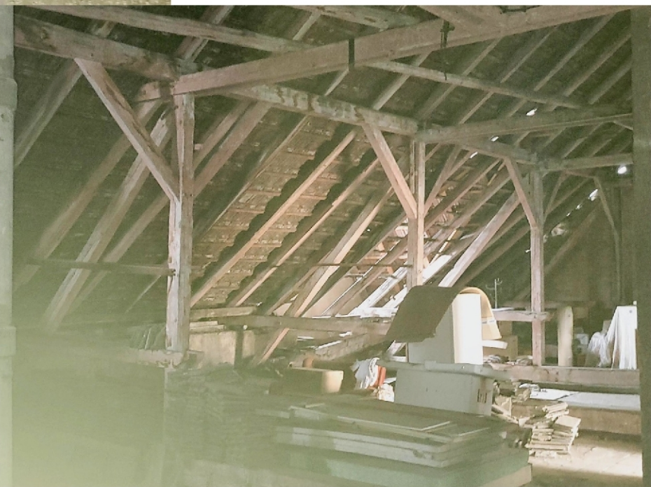
Krov - typické konstrukce krovu
