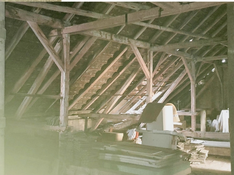
Krov - typické konstrukce krovu
