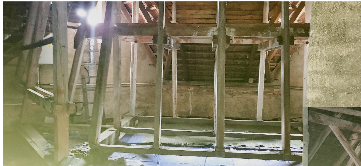
Podkroví - nárožní konstrukce krovu
