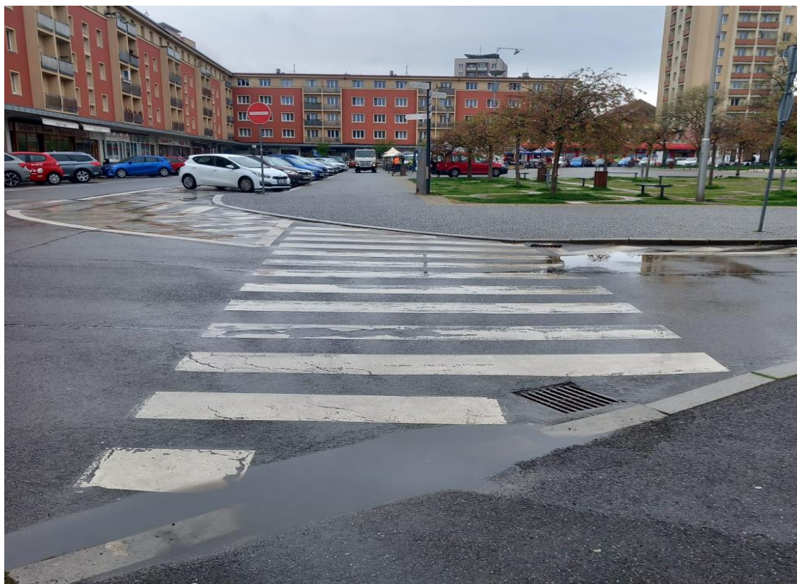
Obrázek č. 2 – NÁM. 17. LISTOPADU – PROPAD OBRUBY
