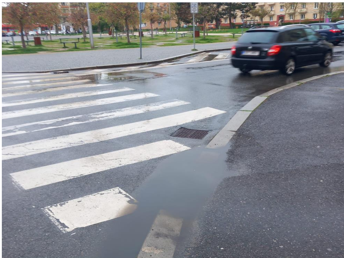
Obrázek č. 2 – NÁM. 17. LISTOPADU – PROPAD OBRUBY
