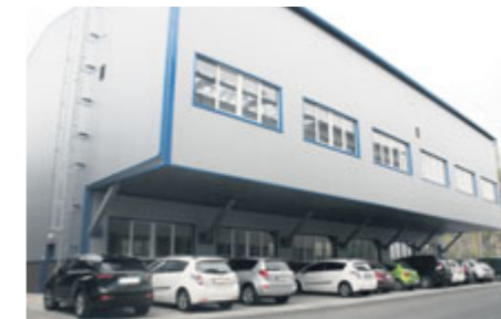
Nová hala, ve které by se mělo začít vyrábět na přelomu tohoto roku. Unikátní řešení spočívá v přenesení výroby do prvního patra.
