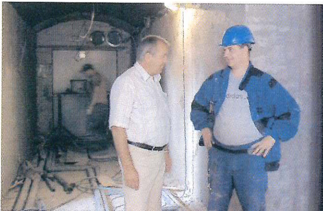
Místostarosta Václav Černý byl 25. srpna v Základní škole Jiráskovy sady a zkontroloval aktuální stav prací, které jsou prováděny v suterénu školy. Vznikají zde nové prostory pro výuku.
