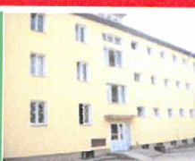
Azylový dům v Příbrami čekají v letošním roce drobné stavební práce. Investorem je město Příbram.
