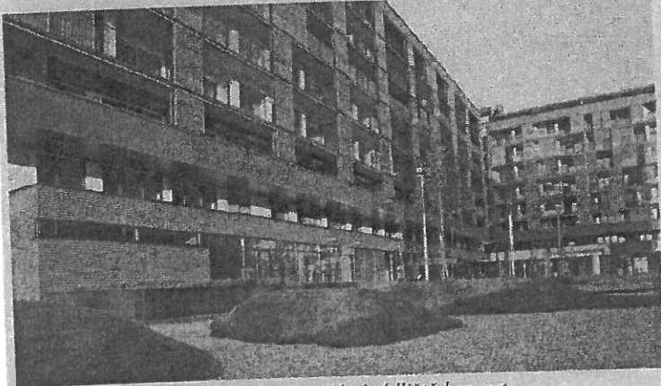
Bytový dům ve Vídni, který je součástí sídliště bez aut
