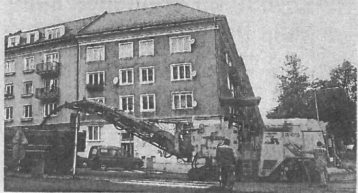
Práce v ulici E. Beneše budou probíhat do 6. října
