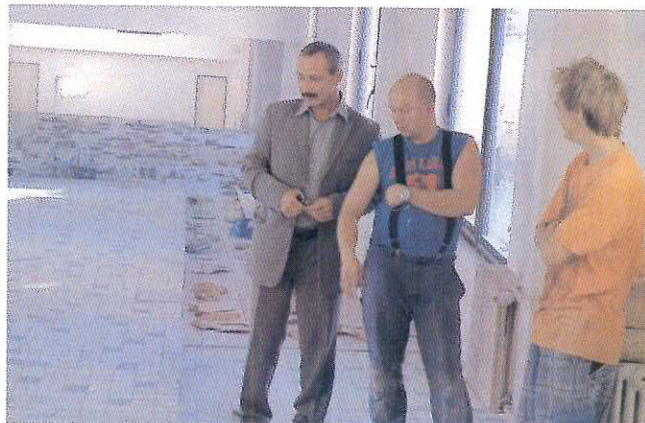
Postup prací na rekonstrukci Základní školy ve Školní ulici sleduje 1. místostarosta MUDr. Ivan Sedivý. Na tuto akci město získalo dotaci.
