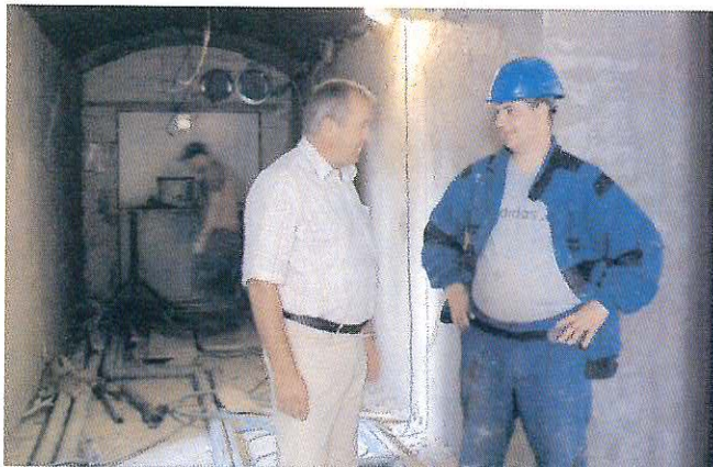
Místostarosta Václav Černý byl 25. srpna v Základní škole Jiráskovy sady a zkontroloval aktuální stav prací, které jsou prováděny v suterénu školy. Vznikají zde nové prostory pro výuku.
