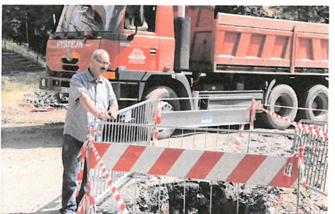
Místostarosta MUDr. Ivan Šedivý na pravidelné kontrole stavebních akcí, které se právě nyní realizují v Příbrami.
