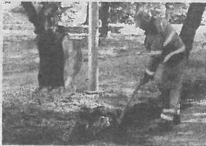
V REKONSTRUKCI je i ulice 28. října. Snímek je ze zahájení prací na silnici. Foto: Deník
