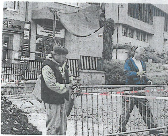
FIRMA CHCE do čtvrtka stihnout opravit 46 metrů čtverečních chodníku.
