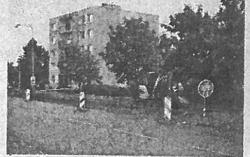
Ve Školní ulici vznikne do konce prázdnin zhruba čtyřicet parkovacích míst
