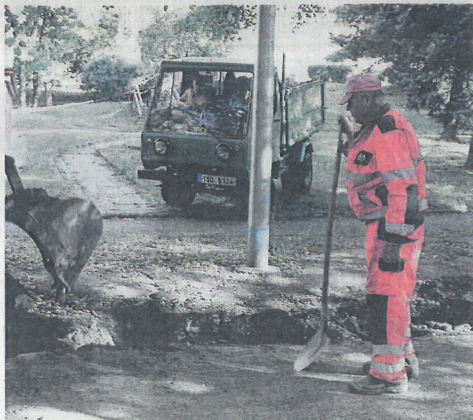
STAVEBNÍ stroje a dělníci jsou už od pondělí v ulici 28. října, která je v rekonstrukci. Uzavírka pro dopravu je mezi ulicí Politických vězňů a ulicí Březohorská a potrvá podle radnice až do 3. srpna. Foto: Martina Janoušková (2x)
