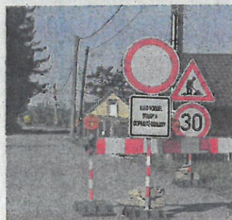
K DALŠÍM UZAVÍRKÁM patří i ta v Oseči, kde se staví kanalizace a vodovod.
