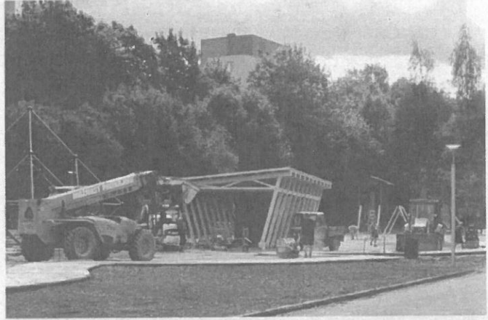
V současné chvíli se na klidové zóně usilovně pracuje, práce by však měly být dokončeny už příští měsíc
