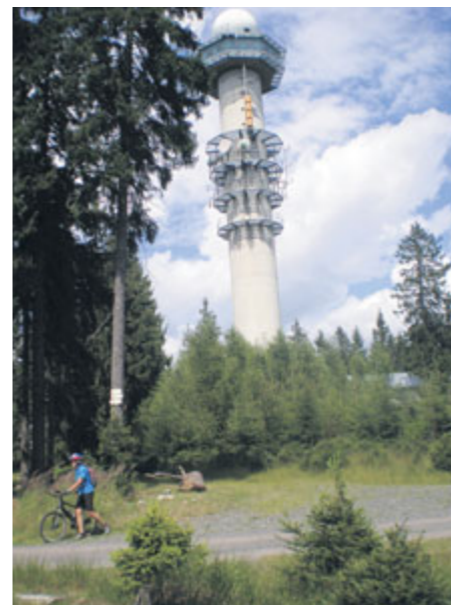
Věž meteorologického radaru na Praze není bohužel přístupná veřejnosti. Foto: autor
