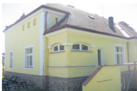
V budově MŠ Rybička byla vyměněna okna.
