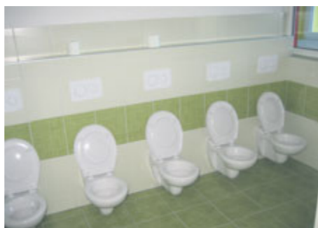
Výsledky rekonstrukcí interiérů jsou vidět na první pohled. Na snímcích srovnání toalet v Mateřské škole Pohádka. Kompletní fotogalerii prázdninových oprav ve školkách najdete na f/mestskyradprijbram .
