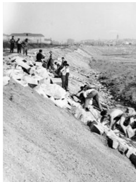
Budování Nového rybníka v rámci Akce Z od roku 1963.
