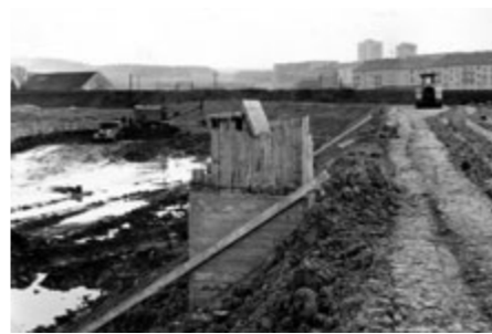
Válčování povrchu zvýšené severní hráze v roce 1962.
