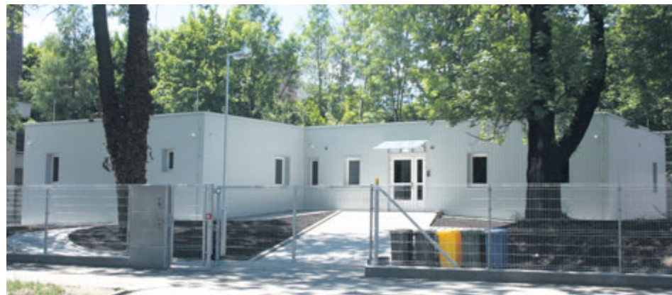
Nové zařízení pro lidi bez přístřeší přispělo ke kultivaci zdevastovaného areálu bývalé mazutky.
