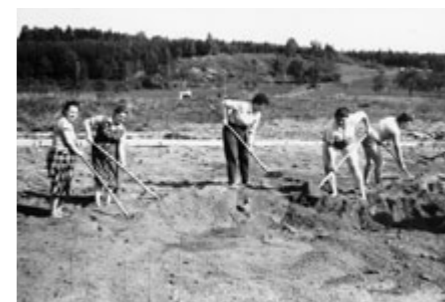
Budování Nového rybníka v rámci Akce Z od roku 1963.
