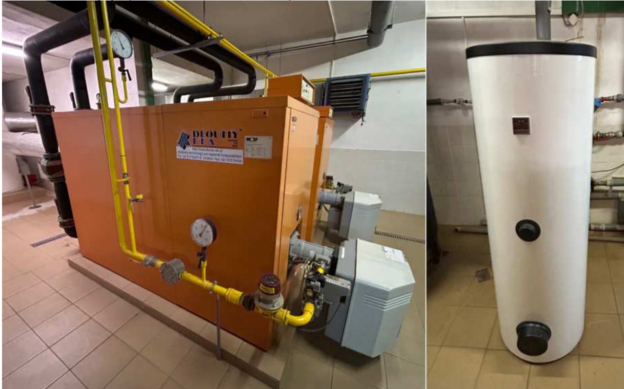
Obr. 2.7.45: Zdroj vytápění (vlevo) a zásobník TV (vpravo)
