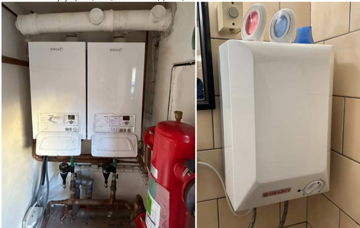
Obr. 2.7.58: Zdroj vytápění (vlevo) a ohřivač TV (vpravo)
