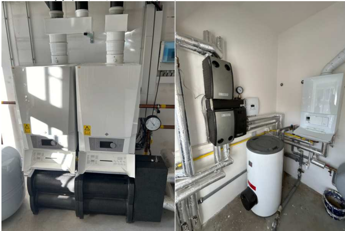
Obr. 2.7.49: Zdroj vytápění (vlevo) a ohřivač TV (vpravo)
