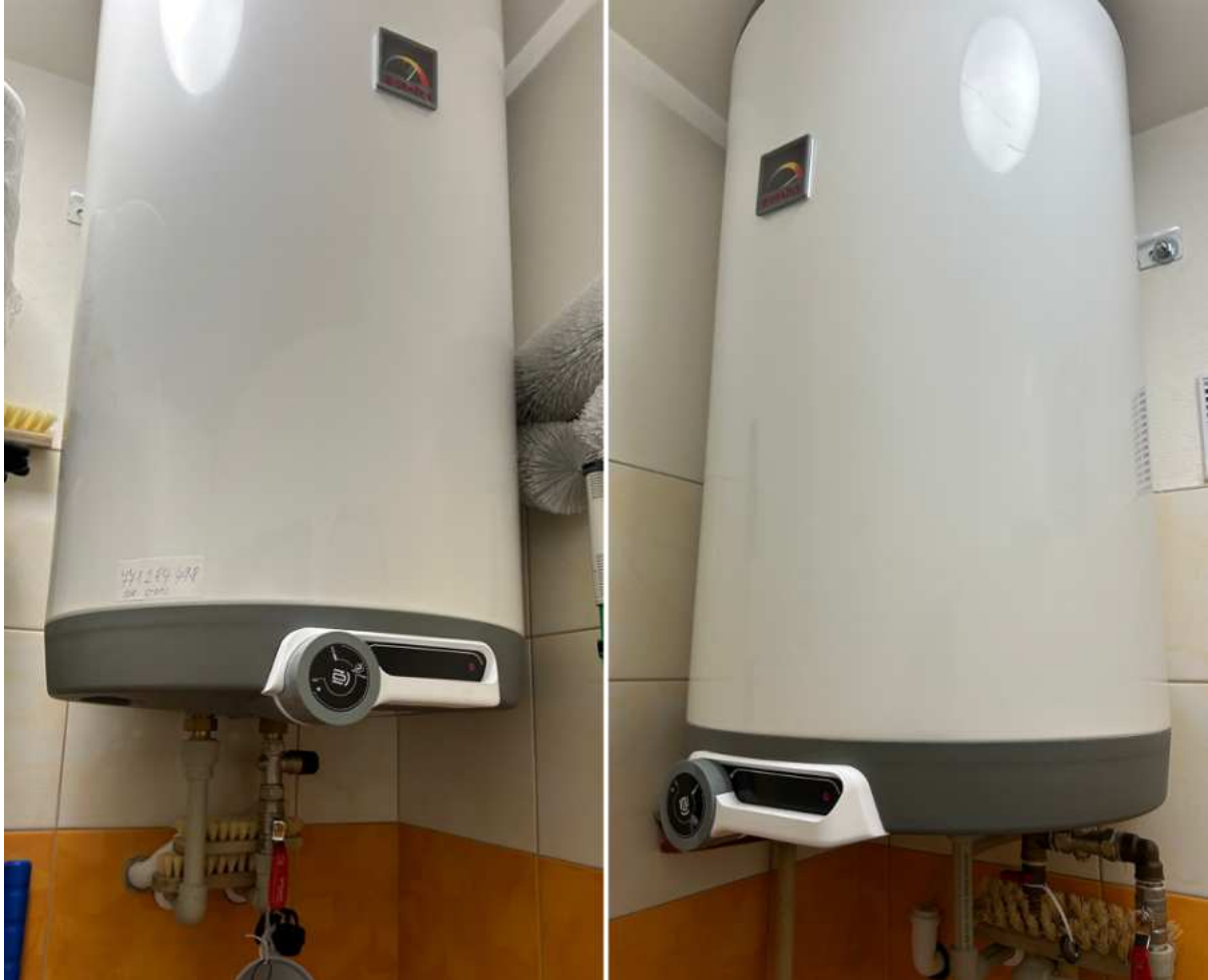
Obr. 2.7.33: Ohřívače TV
