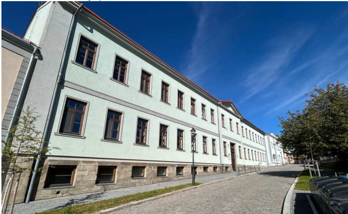
Obr. 2.7.28: ZŠ Březové hory č.p. 337 – fotodokumentace z místního šetření
