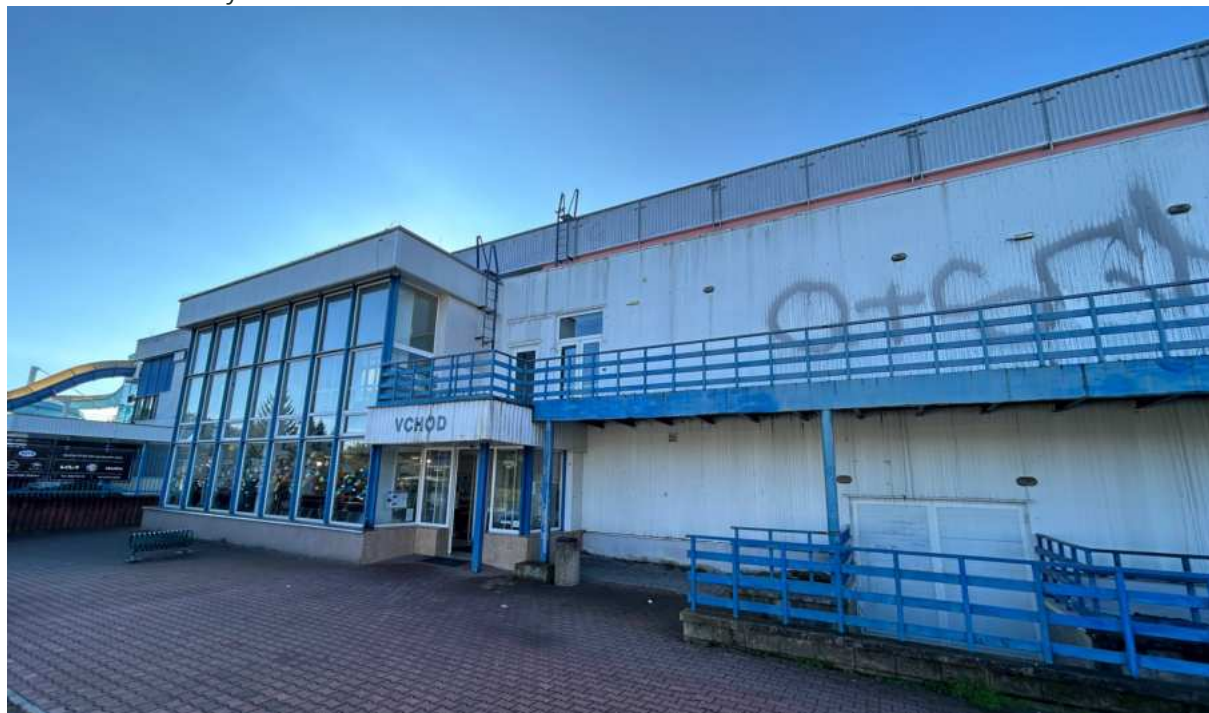
Obr. 2.7.14: Plavecký bazén – fotodokumentace z místního šetření
