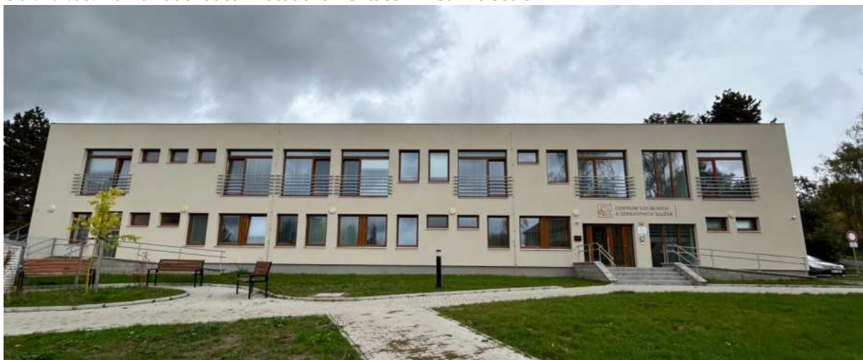
Obr. 2.7.60: Domov důchodců – fotodokumentace z místního šetření
