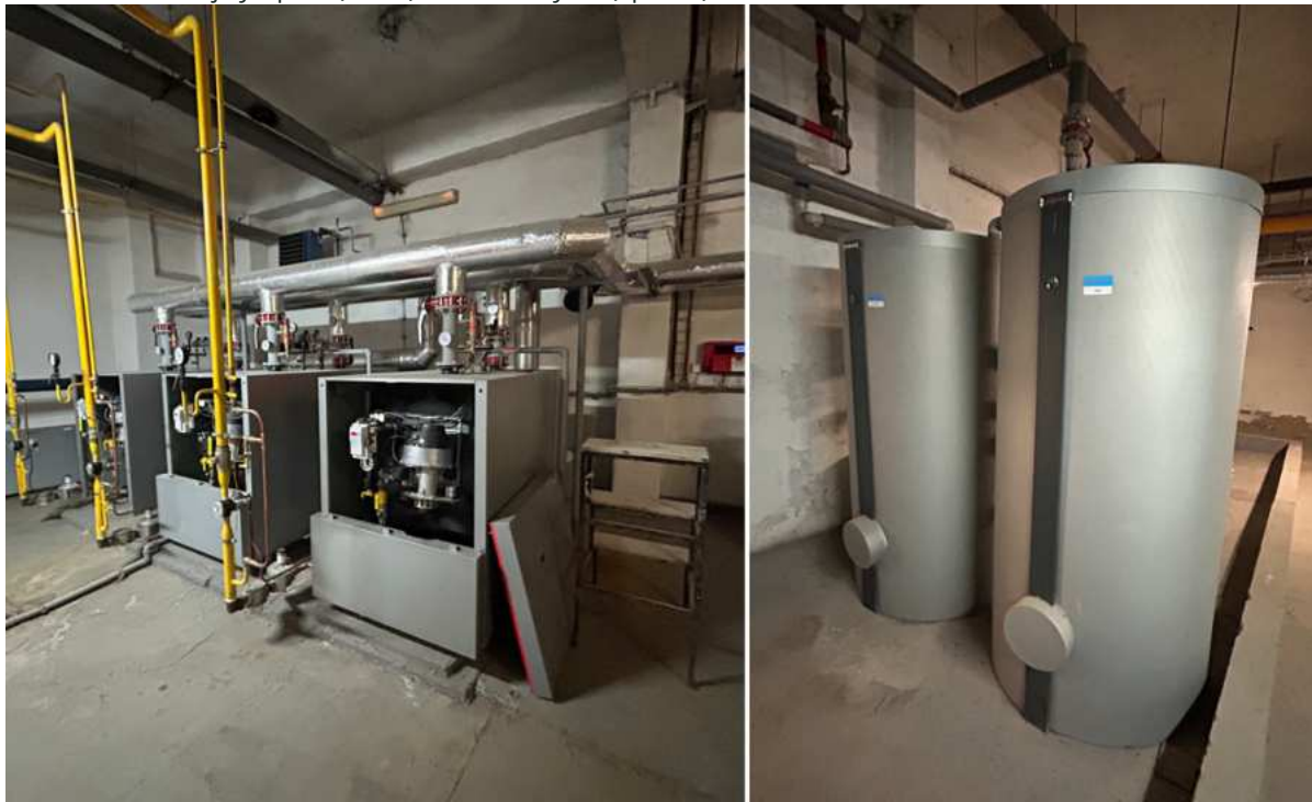
Obr. 2.7.15: Zdroj vytápění (vlevo) a zásobníky TV (vpravo)
