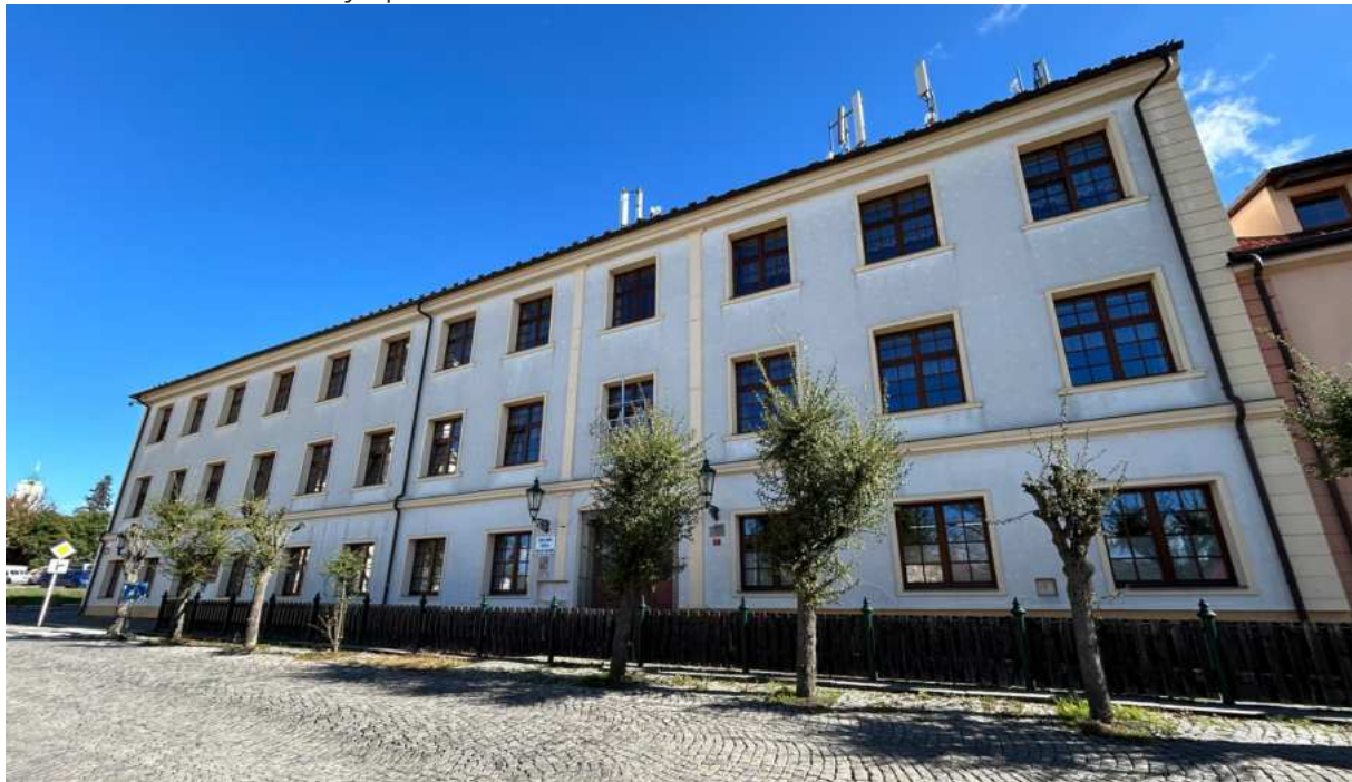
Obr. 2.7.24: ZŠ Březové hory č.p. 1 – fotodokumentace z místního šetření
