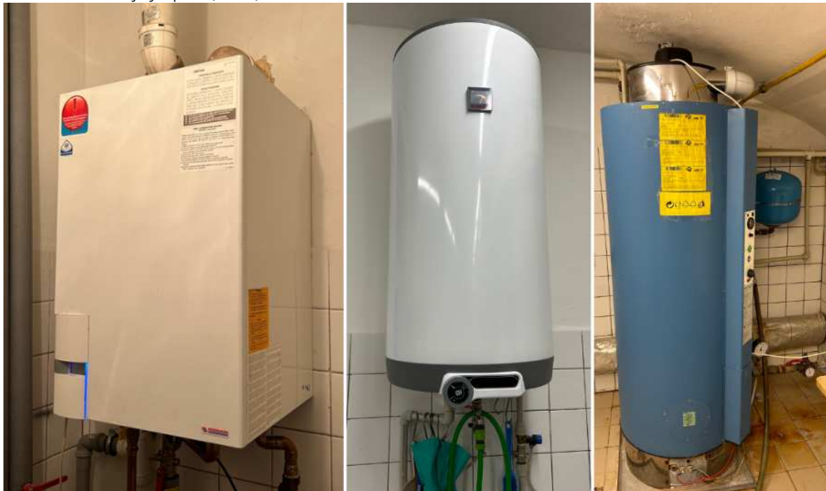
Obr. 2.7.40: Zdroj vytápění (vlevo) a ohřivače TV
