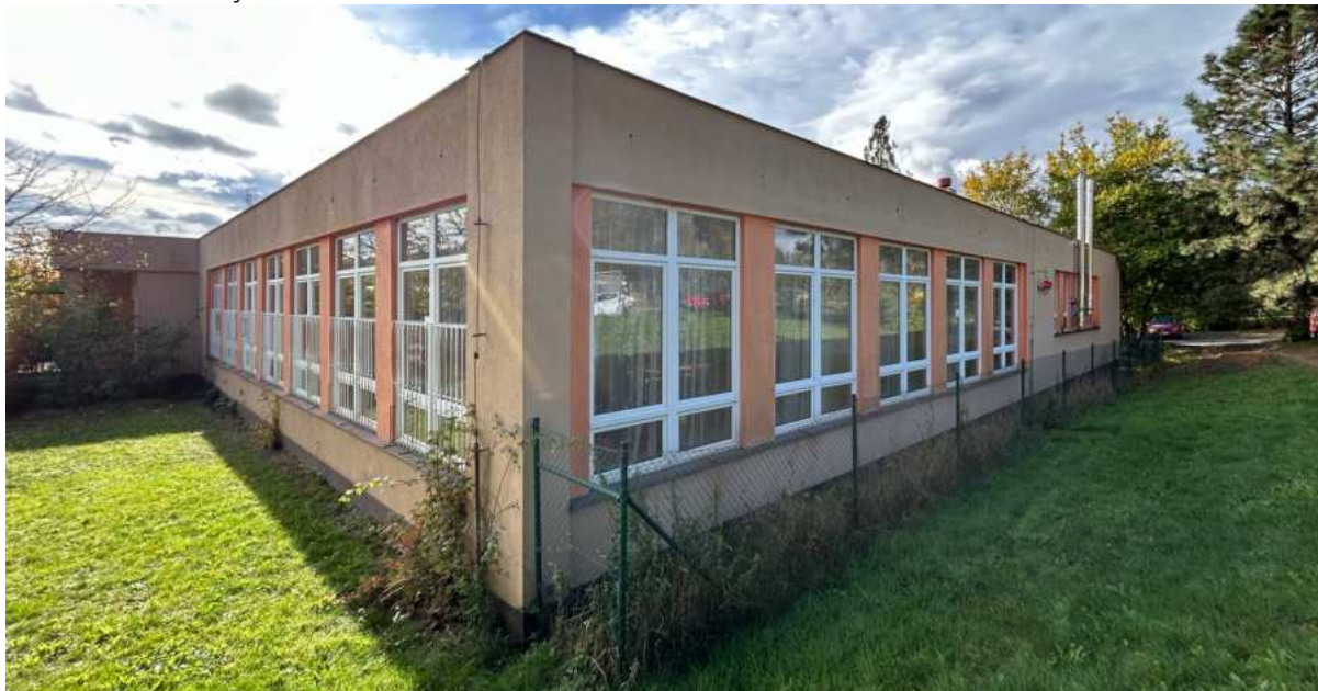
Obr. 2.7.42: Školní jídelna – fotodokumentace z místního šetření
