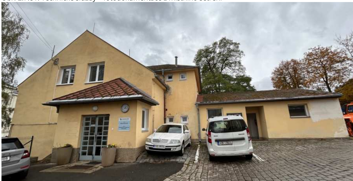
Obr. 2.7.81: Technické služby – fotodokumentace z místního šetření
