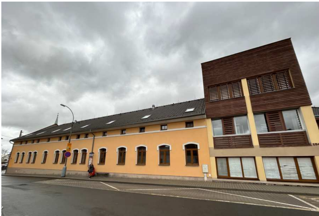
Obr. 2.7.78: CSZS – fotodokumentace z místního šetření
