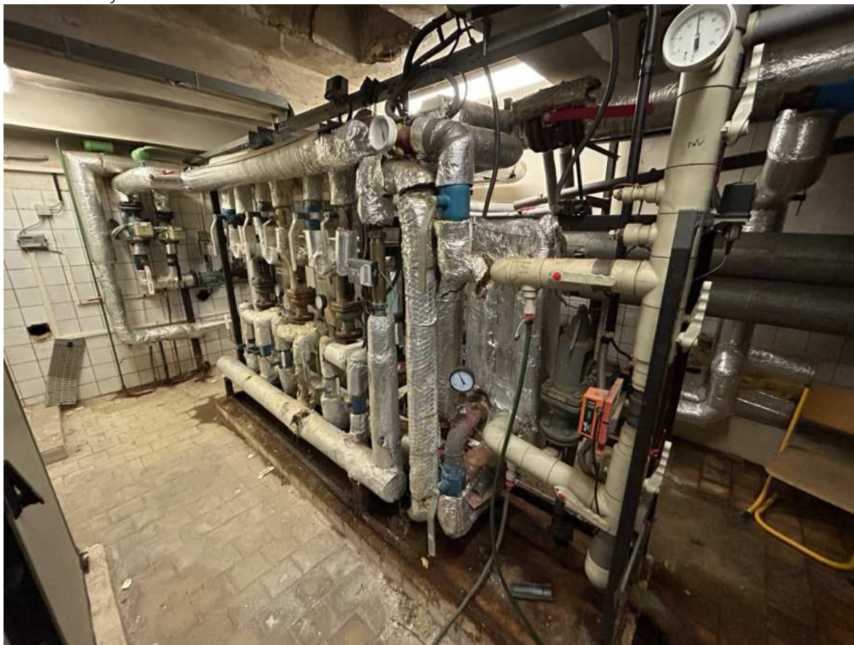
Obr. 2.7.52: Výměníková stanice
