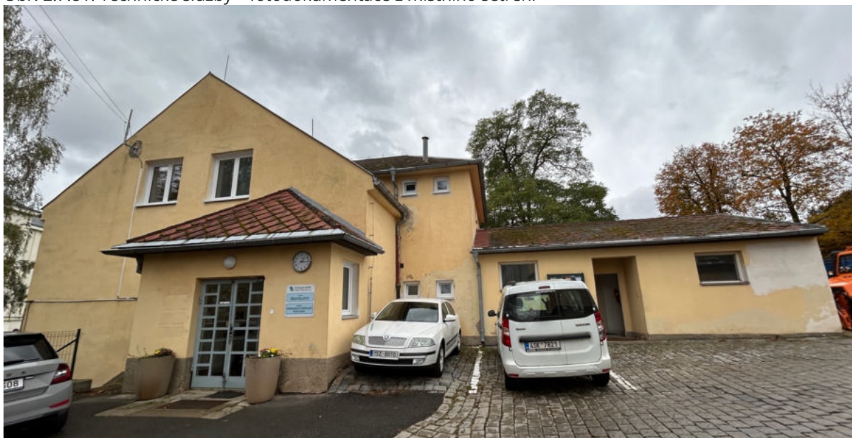
Obr. 2.7.81: Technické služby – fotodokumentace z místního šetření
