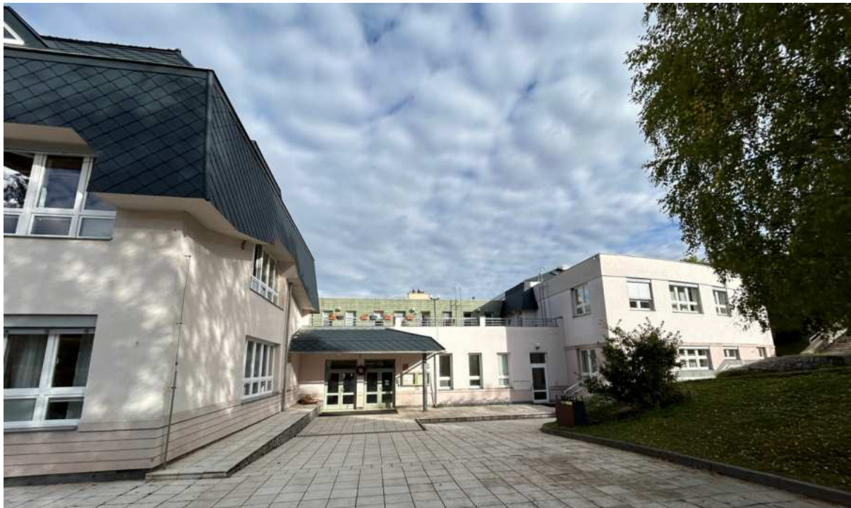
Obr. 2.7.48: ZŠ Waldorfská – fotodokumentace z místního šetření
