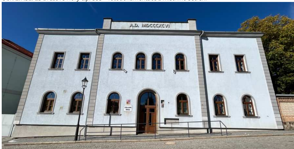
Obr. 2.7.32: ZŠ Březové Hory č.p. 353 – fotodokumentace z místního šetření
