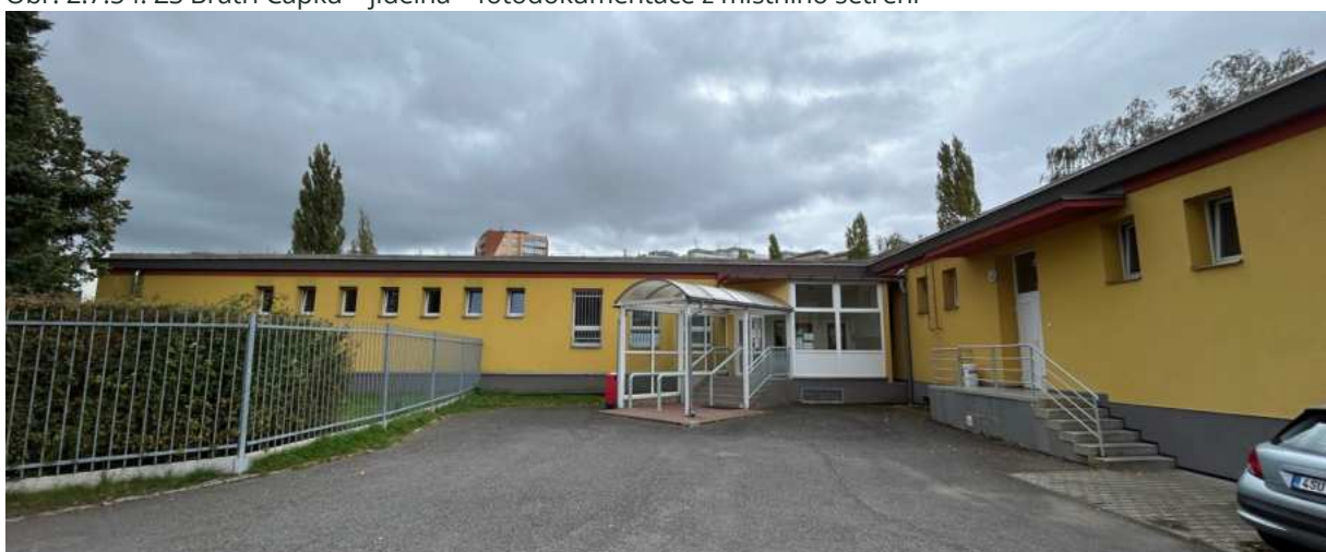
Obr. 2.7.54: ZŠ Bratří Čapků – jídelna – fotodokumentace z místního šetření
