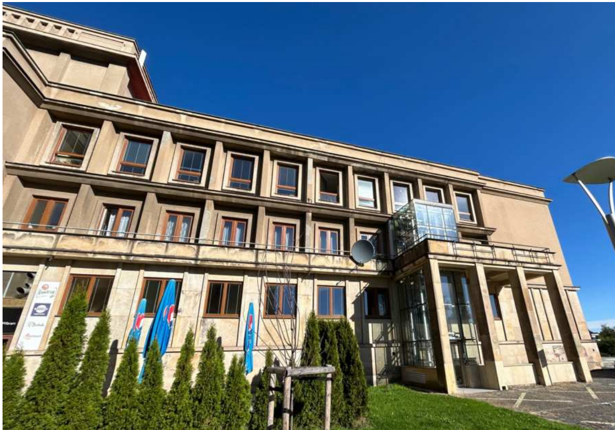
Obr. 2.7.10: Kulturní dům – fotodokumentace z místního šetření
