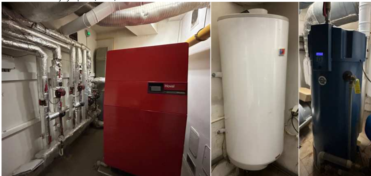
Obr. 2.7.79: Zdroj vytápění (vlevo) a ohřivače TV
