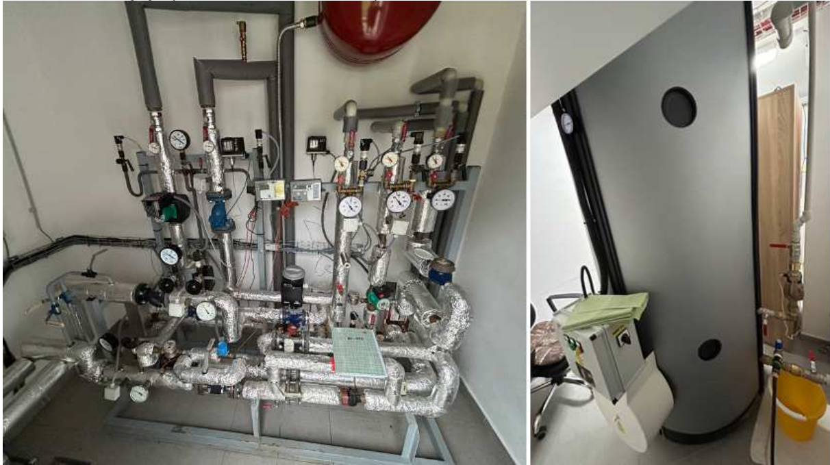
Obr. 2.7.61: Zdroj vytápění (vlevo) a ohřevač TV (vpravo)
