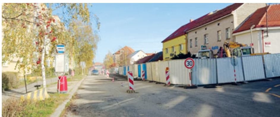
V části Milínské byly kompletně vyměněny vodohospodářské sítě.
