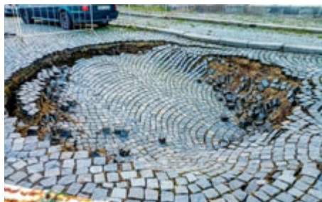
Propad, ke kterému došlo na konci září, opravuje státní podnik Diamo. Mimo jiné vybudoval dosýpací otvory.
