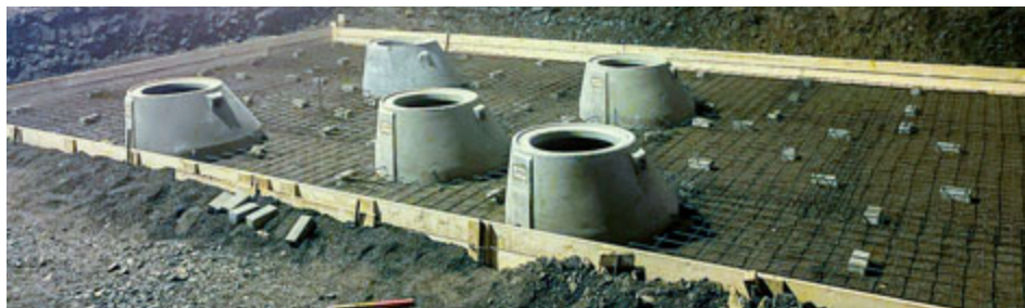
Propad, ke kterému došlo na konci září, opravuje státní podnik Diamo. Mimo jiné vybudoval dosýpací otvory.
