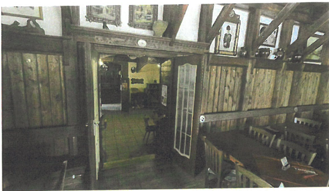
Nové dveře ze stávající restaurace do sálu. Byl vybourán otvor do stávající zdi.
