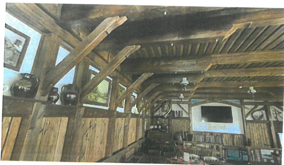
Trámový strop s podhledem, dřevěné sloupy, obložení stěn palubkami, „bílá místa“ – sádkartonový obklad (pouze ostění omítky)
