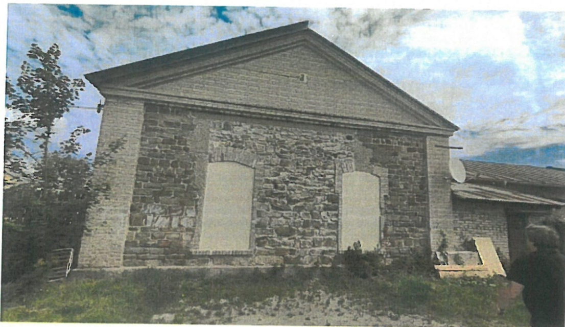
Zadní pohled na objekt – obnovená a zazděná okna po původních vratech
