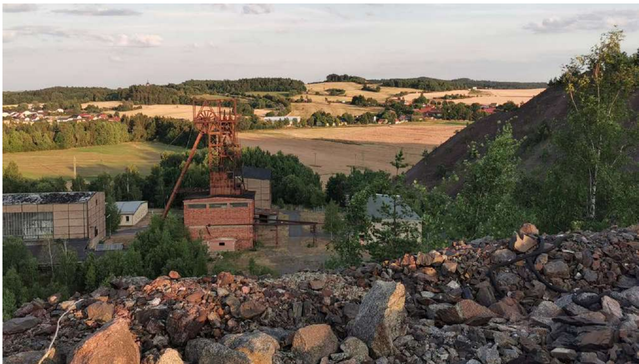
pohled na důlní věž v uzavřeném areálu
