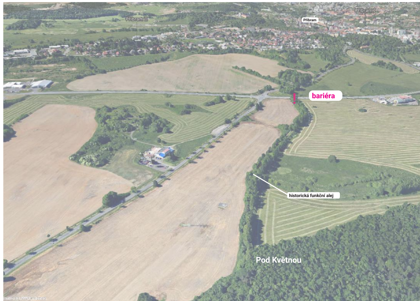
pohled od Květné směrem na centrum (zdroj:mapy.cz)
