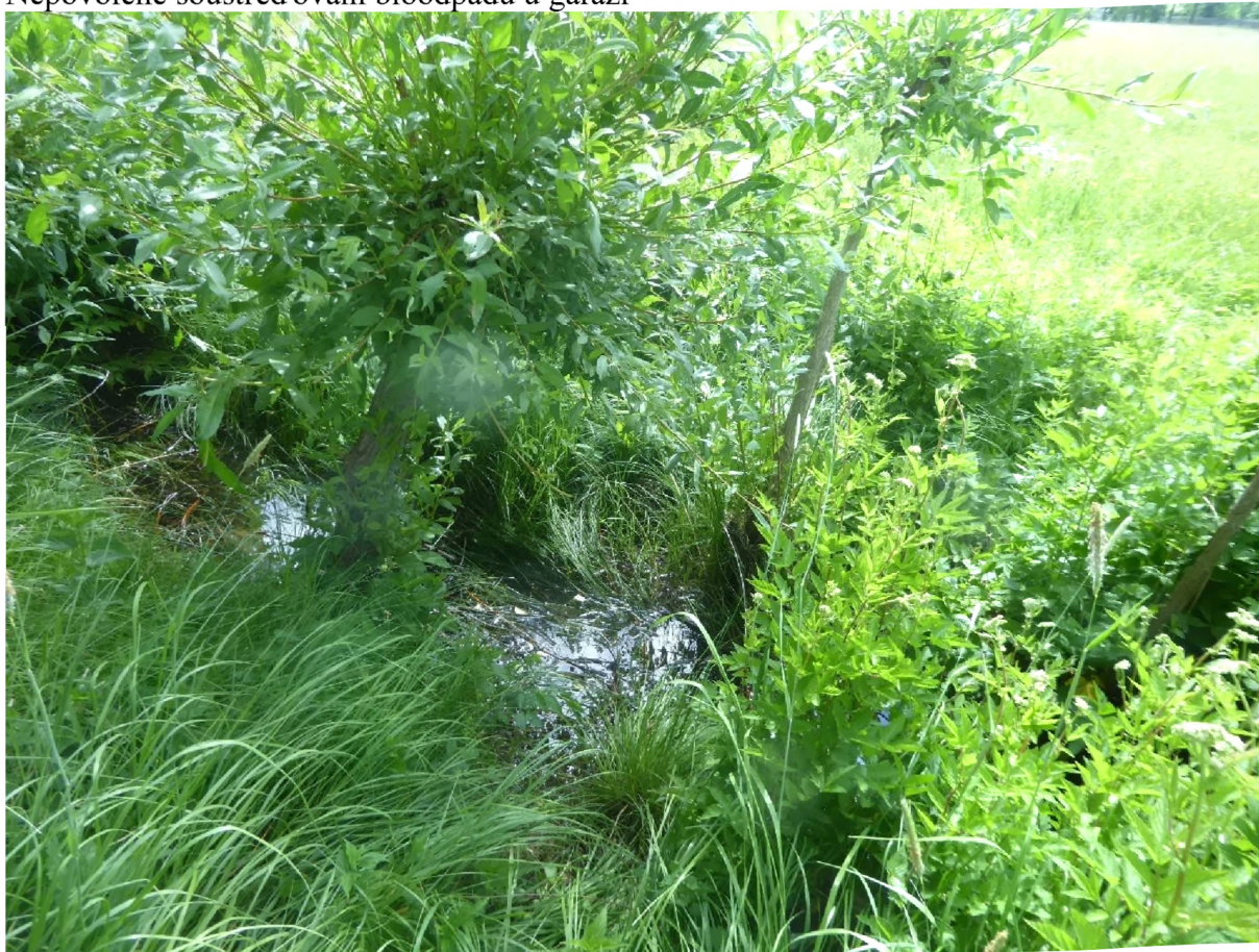
Stav odvodňovacích struh
