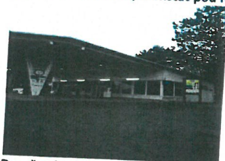
Čerpací stanice PHM, Frenštát pod Radh.
