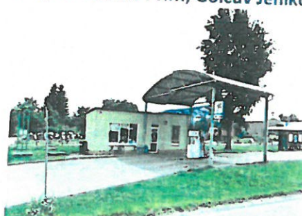
Čerpací stanice PHM, Golčův Jeníkov
