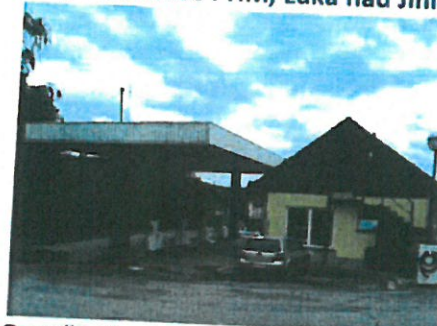
Čerpací stanice PHM, Luka nad Jihlavou
