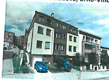
Administrativní budova, Brno-Vinohrady
