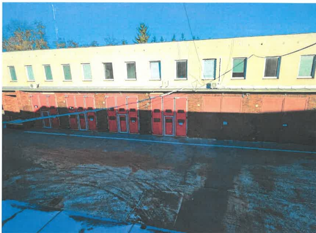
Kontrast stávajících ručně ovládaných plechových křídlových vrat a nových skládacích vrat s dálkovým technologickým ovládáním výjezdu z KOPIS HZS STČ
